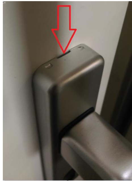
Cover klikkes af med skruetrækker i bund og top
