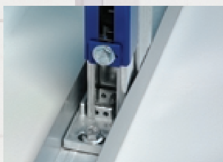
Indbygning i stålskeletvæg
