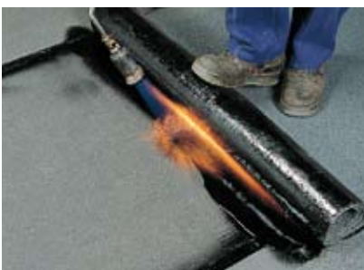
Et "bad" af smeltet bitumen foran rullen
