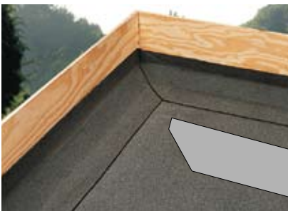
Indvendigt hjørne: Anden understrimmel vist som principskitse
