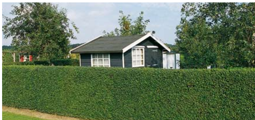
Du kan hurtigt og nemt få en ny tagdækning på havehuset med Selvbyggerpap
