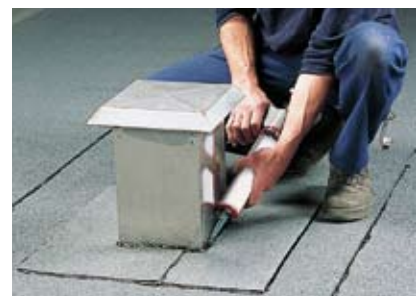
Til sidst fuges langs kanten
