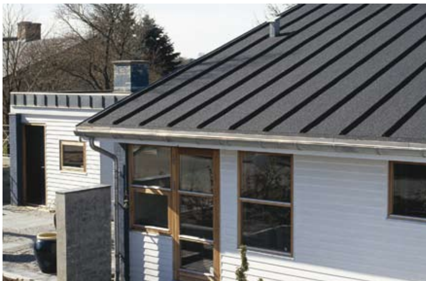
Dette hus havde nedslidte eternitbølgeplader, inden det blev renoveret med tagpap.
