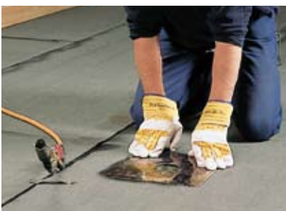
Tagbrønden trykkes fast i den smeltede bitumen
