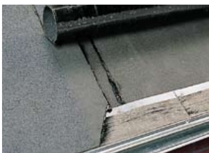
Ved 2-lagsdækning monteres tagfodsblikket oven på underste lag tagpap
