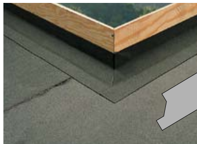
Udvendigt hjørne: Anden understrimmel vist som principskitse
