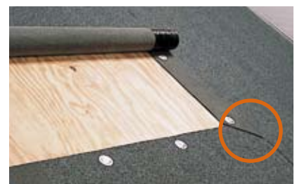
Hjørnet snittes, inden endeoverlægget lukkes
