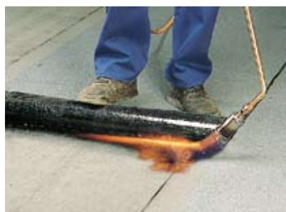
Ret brændehovedet mod kanten
