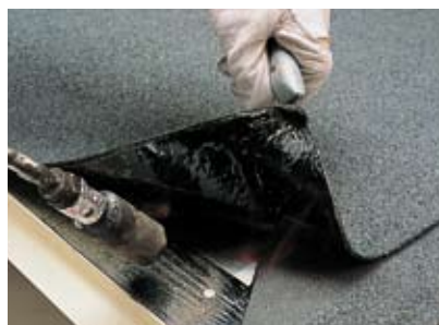
Hold hjørnet oppe med kniven
