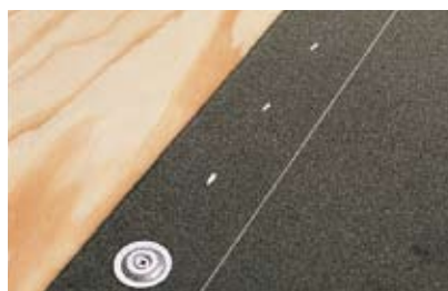
Markering pr. 10 cm gør det nemt at placere skruerne
