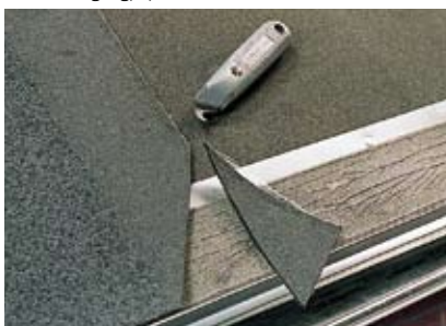
Snit hjørnet for pæn afslutning
