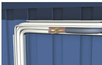
26. Nå er rørene forlenget og sammenkoblet. Neste trinn er å føre dem frem til utedelen. Drenslangen som leder ut kondens fra innedelen ved
