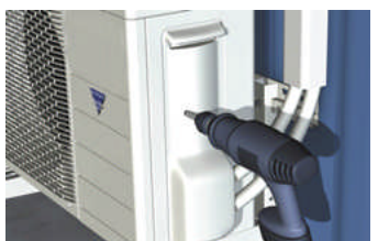
37. Skru på dekselet til el- og gassrørkoblingene.
