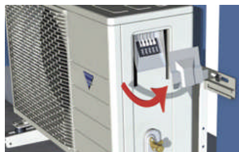
23. Ta av platen som sitter foran elkoblingene. Vent med å installere (kommer først i pkt. 33)
