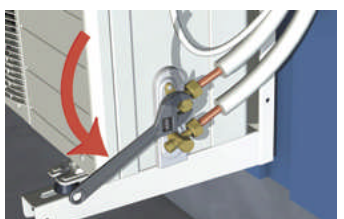
33. Skru av hettemuttrene ytterst på koblingstappen. Innenfor er det en ventil for å slippe gass ut i rørene.
