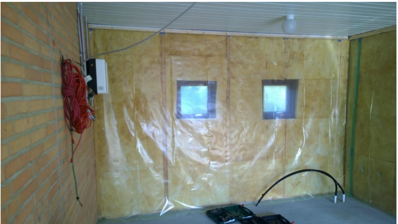
Efter 200mm. placeres en kraftig dampspærrer folie, som tapes med DAFA folietape.
