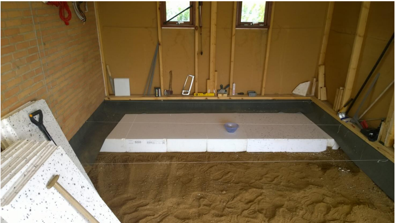
Det nederste lag Sundolitt (220mm.), ligges på afrettet sand.
