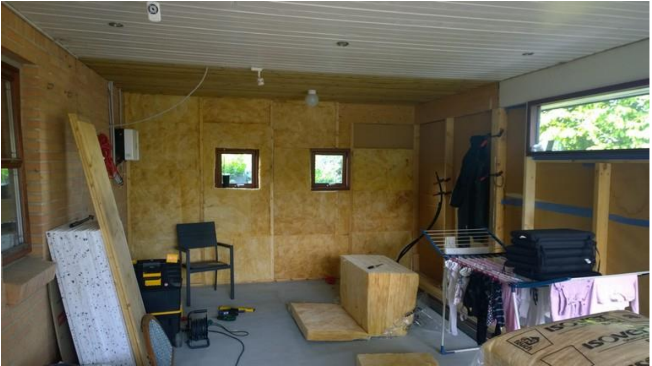
Så påbegyndes isolering med ISOVER. I alt ca. 250mm., i tre lag.
