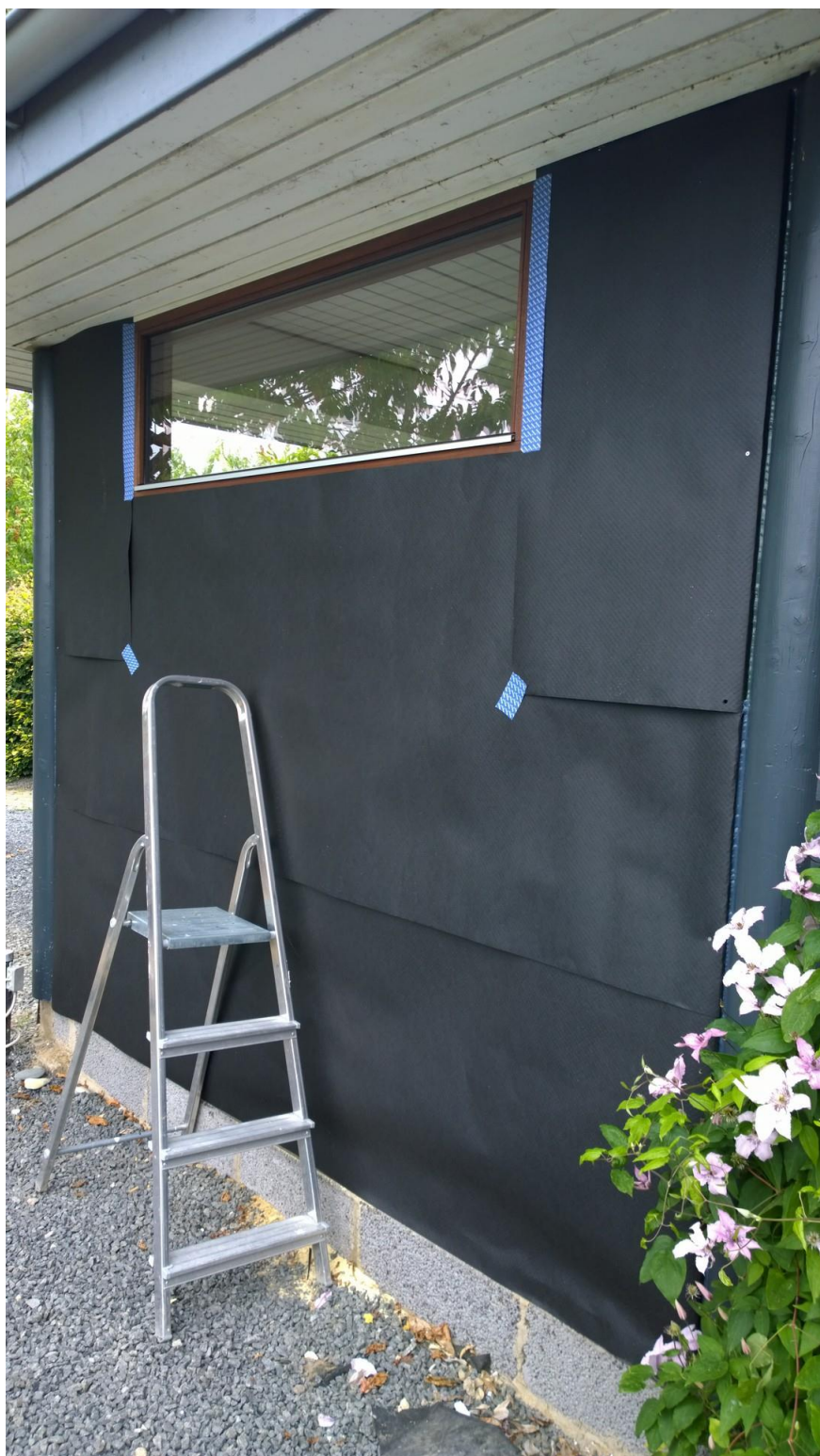
Der monteres vindpap på den sidste ydervæg inden der monteres træbeklædning.
